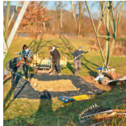
Costruzione di uno stagno direttamente sotto un traliccio
